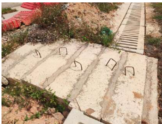
施工期排水沟（现已废除）
