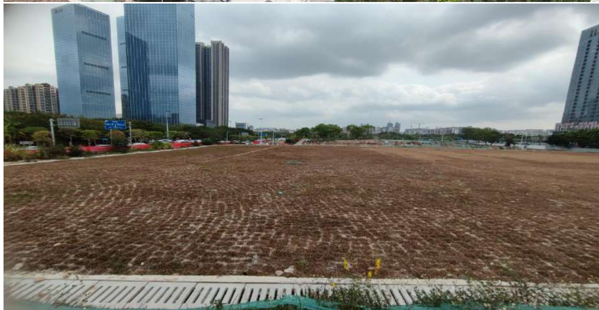
现场无人机照片
