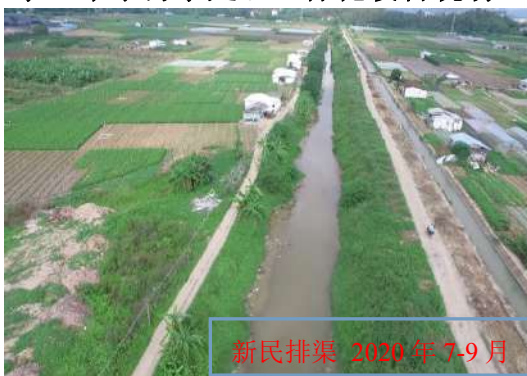
新民支渠清淤后现状(2)
