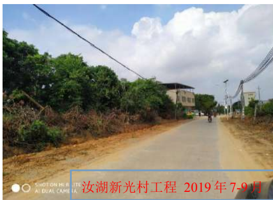
H线施工后周边现状
