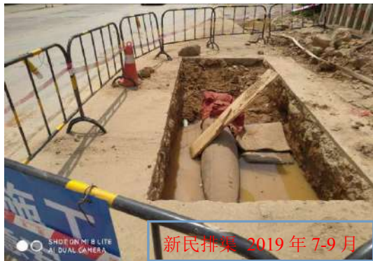
东江大道一侧施工现状 (1)
