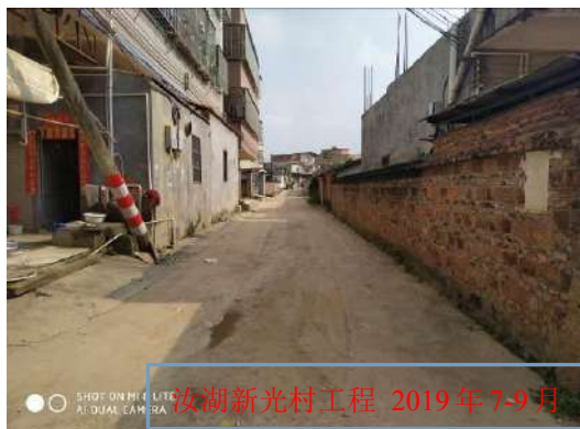
M线施工后周边现状
