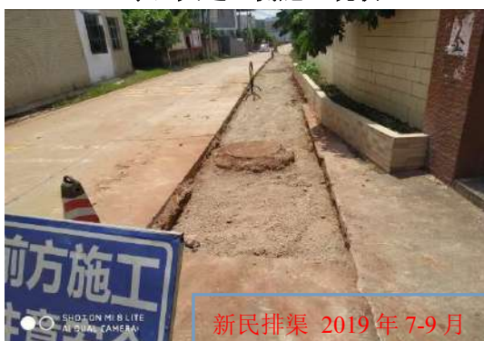
下源村施工现场 (1)
