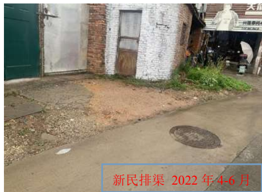
B线施工后周边现状
