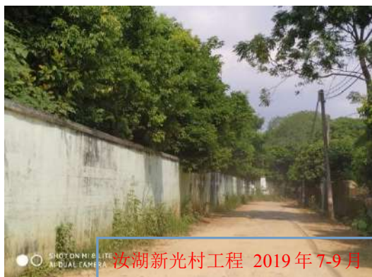
B线施工后周边现状
