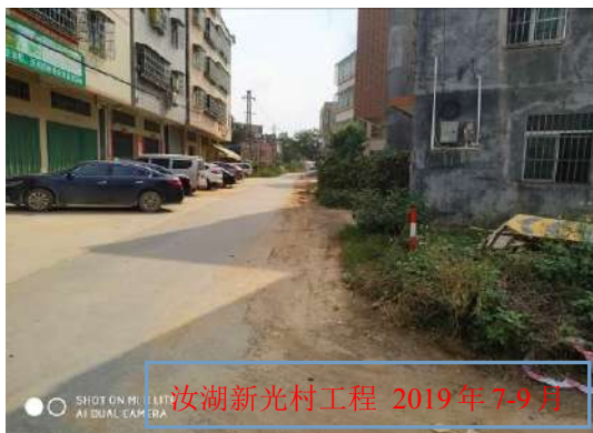
K线施工后周边现状
