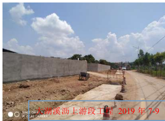
Y227 县道一侧截污管施工现场
