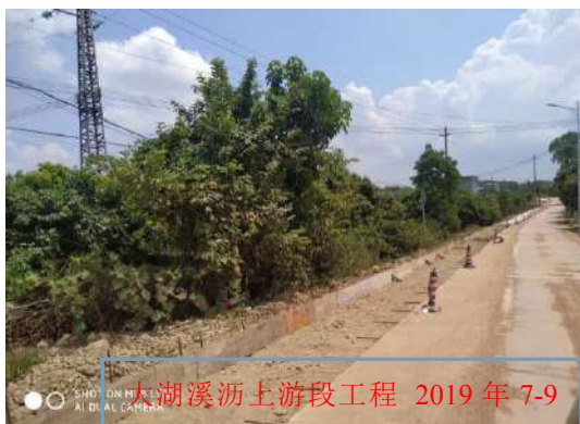
Y227 县道一侧截污管施工现场
