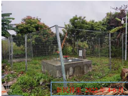
A线一体化泵站现状
