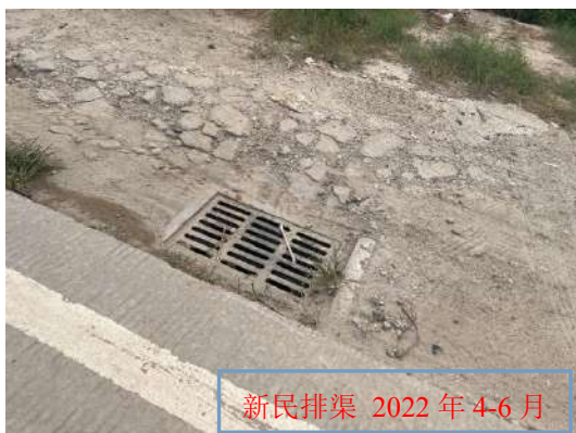
K线施工后周边现状
