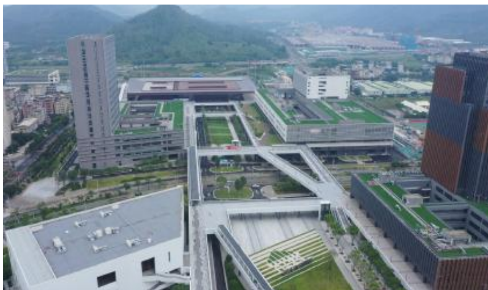
现场无人机照片
