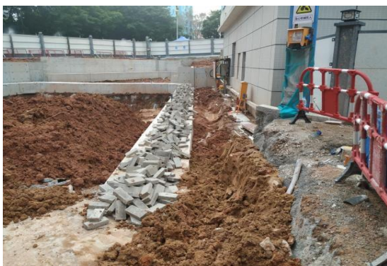
基坑顶北侧在建排水沟
