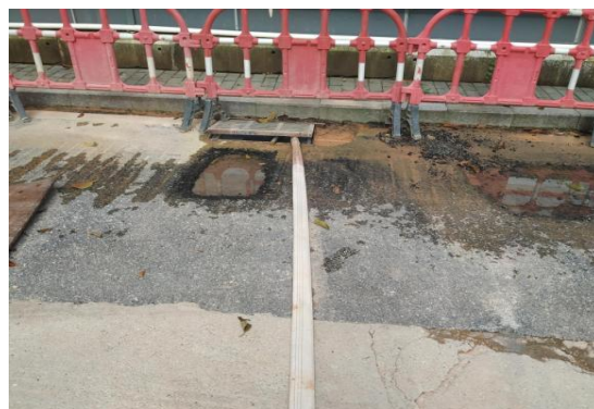
项目内排水沟
