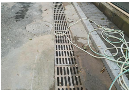
项目区排水沟
