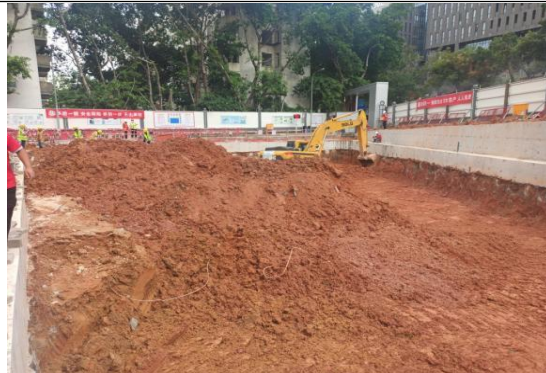
污水池站基坑底施工现状
