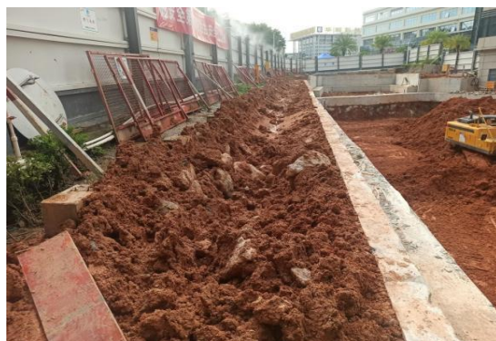
基坑顶南侧在建排水沟
