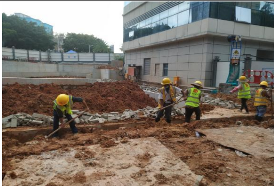
东侧施工现状
