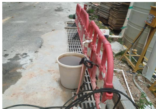
项目区排水沟
