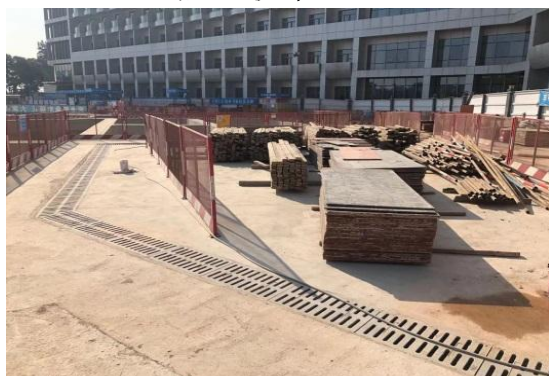
基坑顶排水沟 (1)
