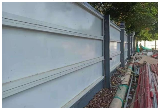
施工围挡现状1
