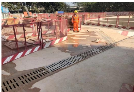
基坑顶排水沟 (2)
