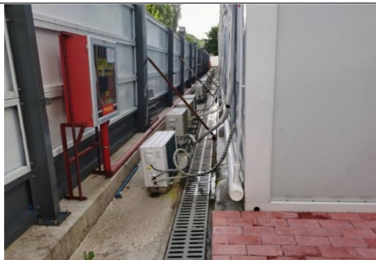
临时排水沟及施工围挡
