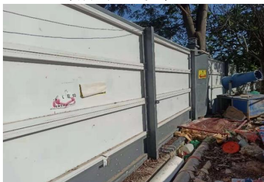
施工围挡现状2
