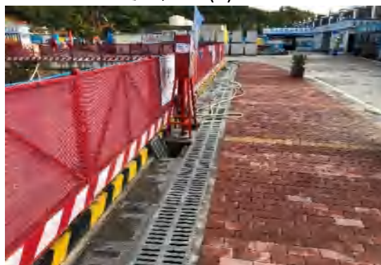
基坑顶排水沟 (2)
