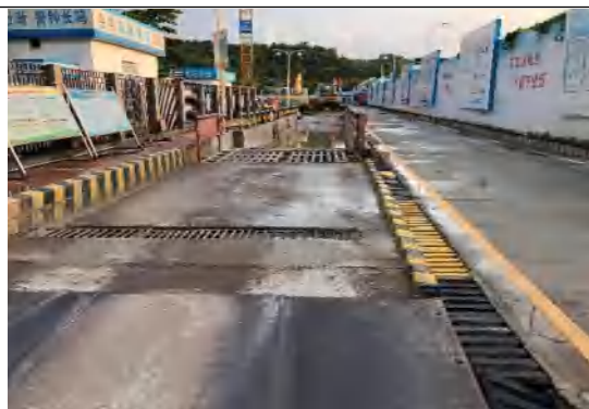
项目出入口沉砂池
