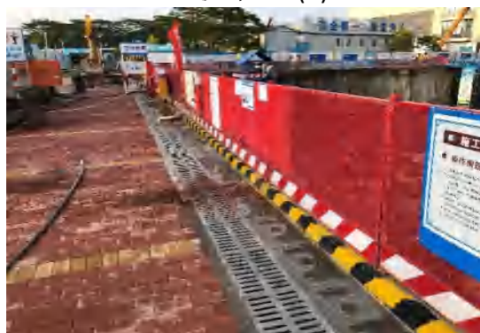
基坑顶排水沟 (1)
