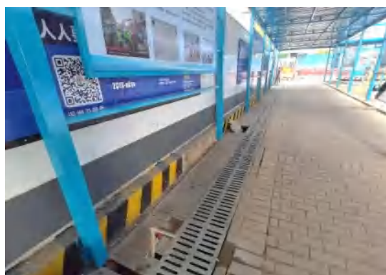
安全通道排水沟
