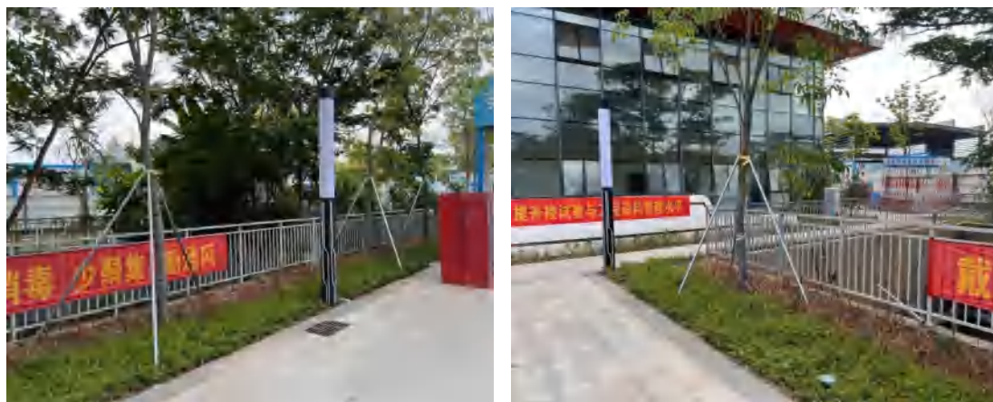
永久水土保持措施现状
