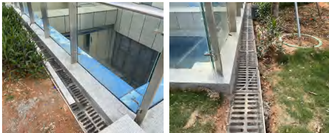
永久水土保持措施现状
