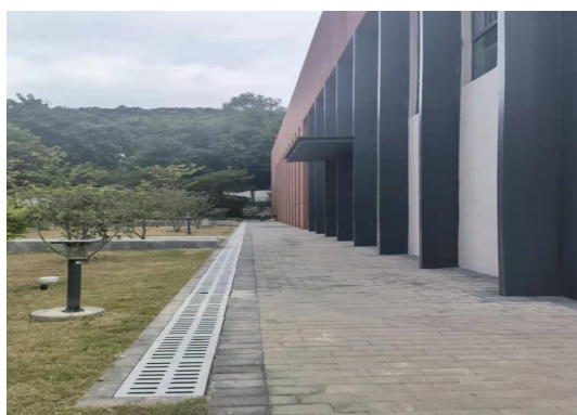
项目永久排水沟及绿化
