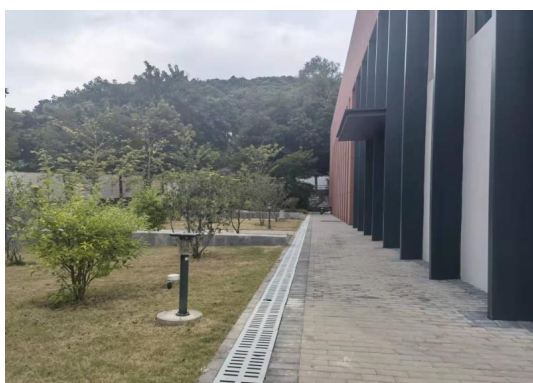
项目永久排水沟及绿化
