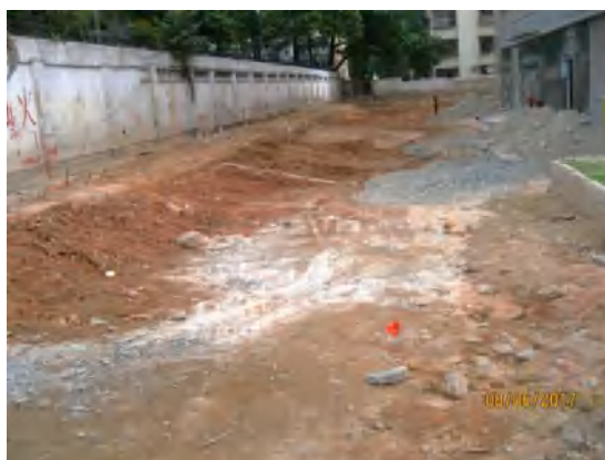
项目西侧道路施工
