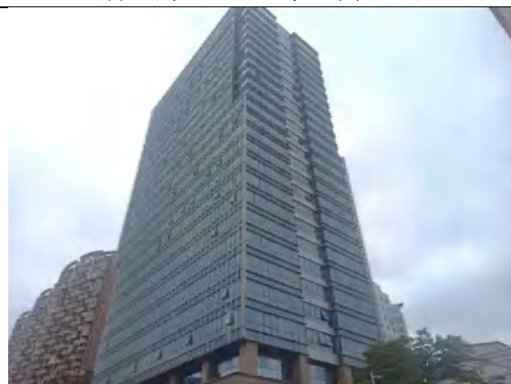
项目主体建筑东南侧
