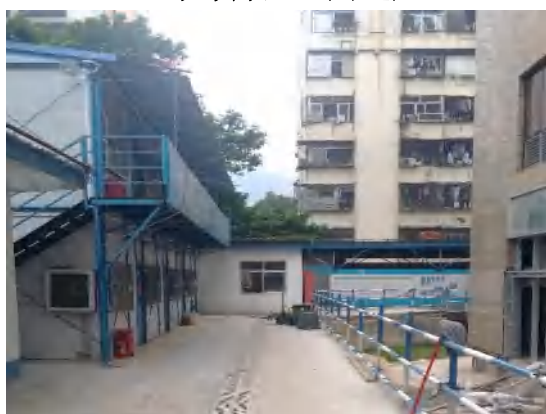
施工营地及硬化
