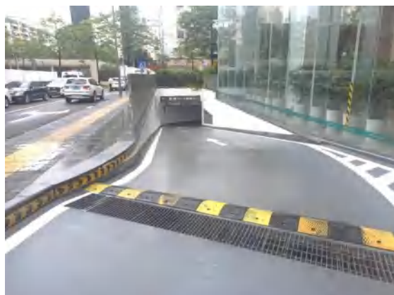
项目地下车库入口及排水沟
