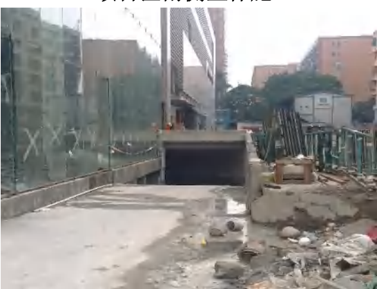
地下车库入口周边施工
