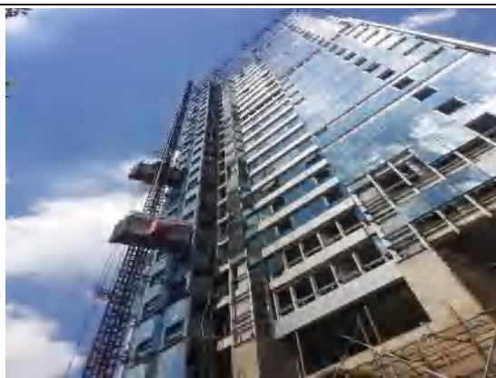
项目主体施工
