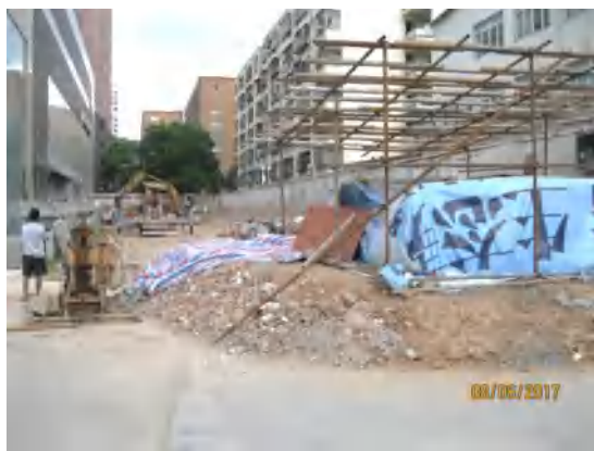
项目北侧道路施工 2
