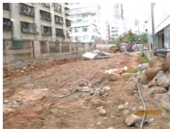
项目北侧道路施工 1
