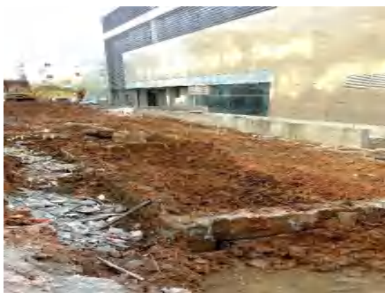
项目区北侧开挖基坑回填 2
