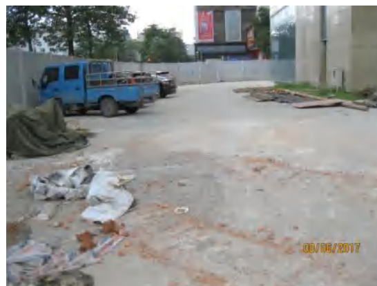
项目东侧临时硬化
