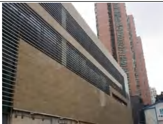
项目区西北侧主体施工
