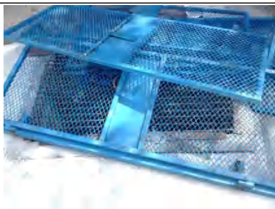
基坑坑底北侧临时排水沟
