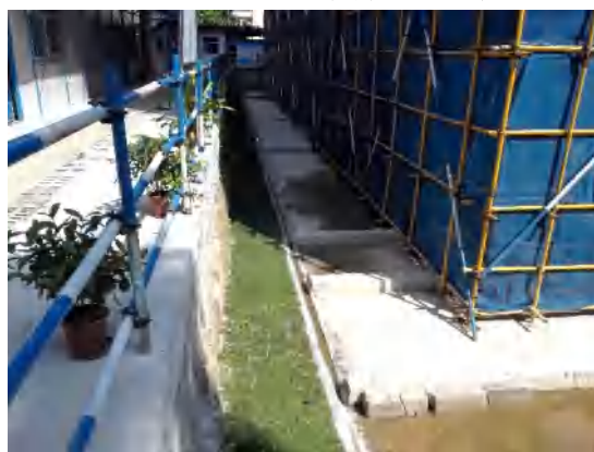
西侧基坑回填去硬化及绿化
