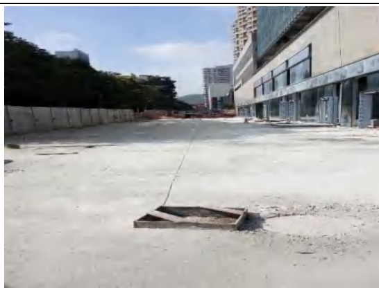
建筑南侧硬化及雨水管
