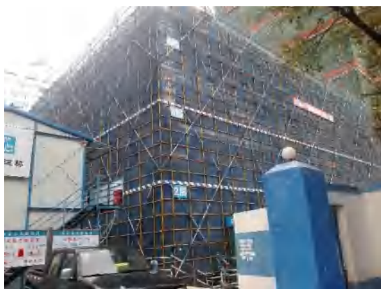
项目区南侧主体施工
