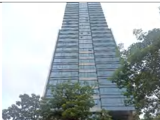
项目主体建筑东侧
