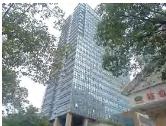
项目主体建筑东北侧
