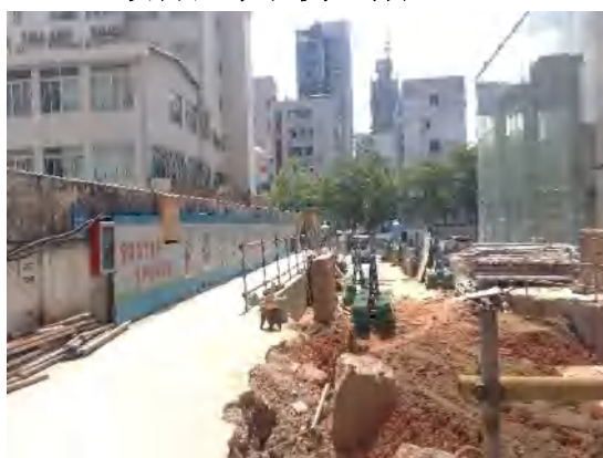
项目北侧施工
