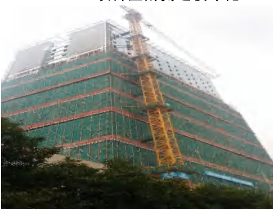
项目区东北侧主体施工
