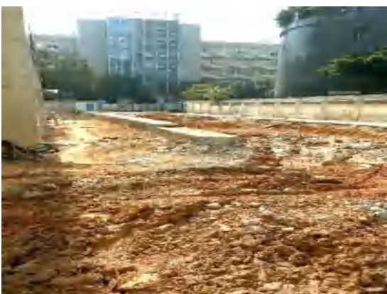
项目区北侧开挖基坑回填 1
