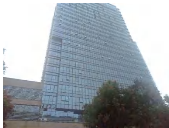
项目主体建筑南侧
