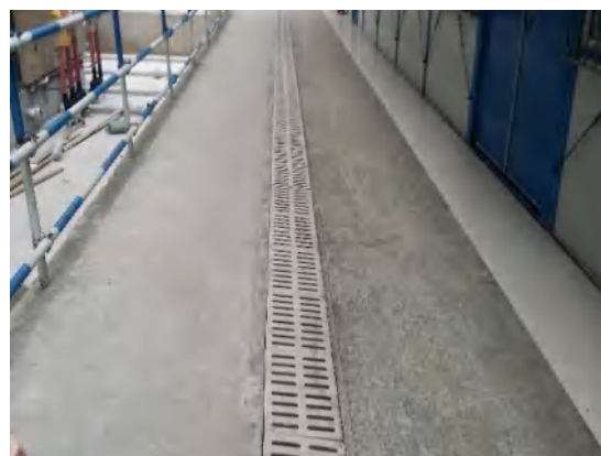
项目临时排水沟
